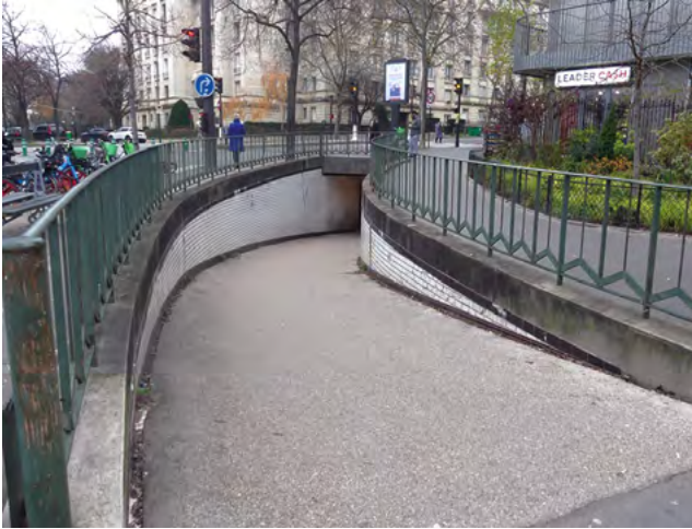
Souterrain porte d'Auteuil sans aucune indication
