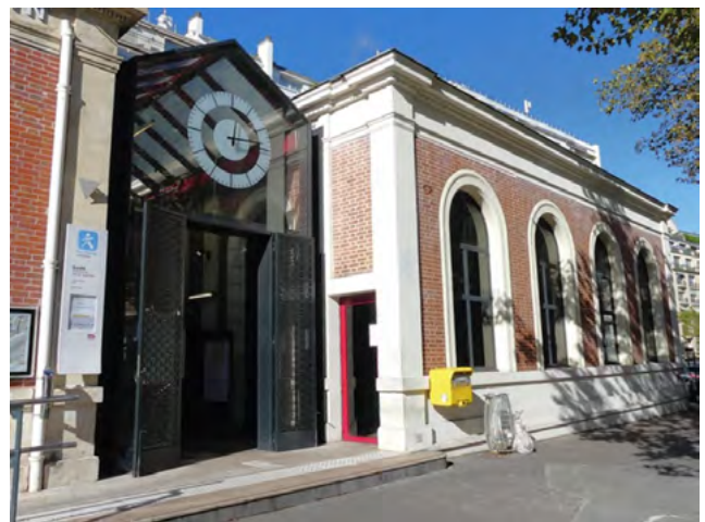
Station Henri Martin RER-C dépourvue de tout balisage vers le Bois
